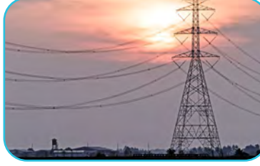
Görsel 5.1.2: Elektrik tellerinde genleşme
